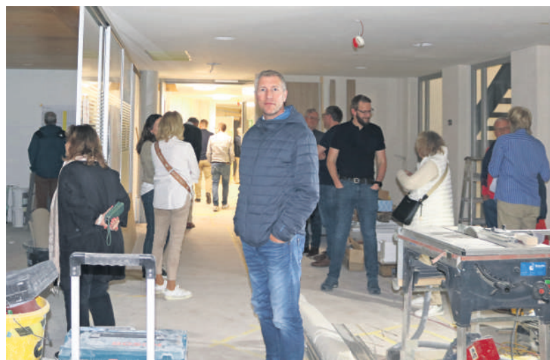
Der Eingangsbereich im ersten Stock ist noch eine Baustelle.
